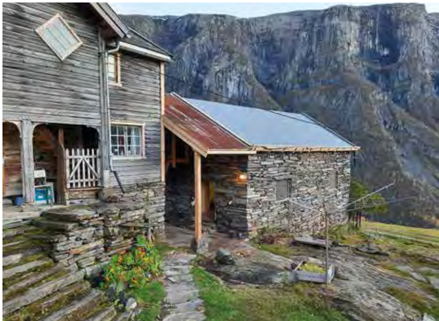
Nytt tak på steinstova og mellomgangen.
